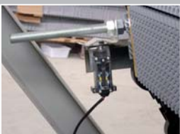
Выключающая тяга блокировки цепи ступеней
